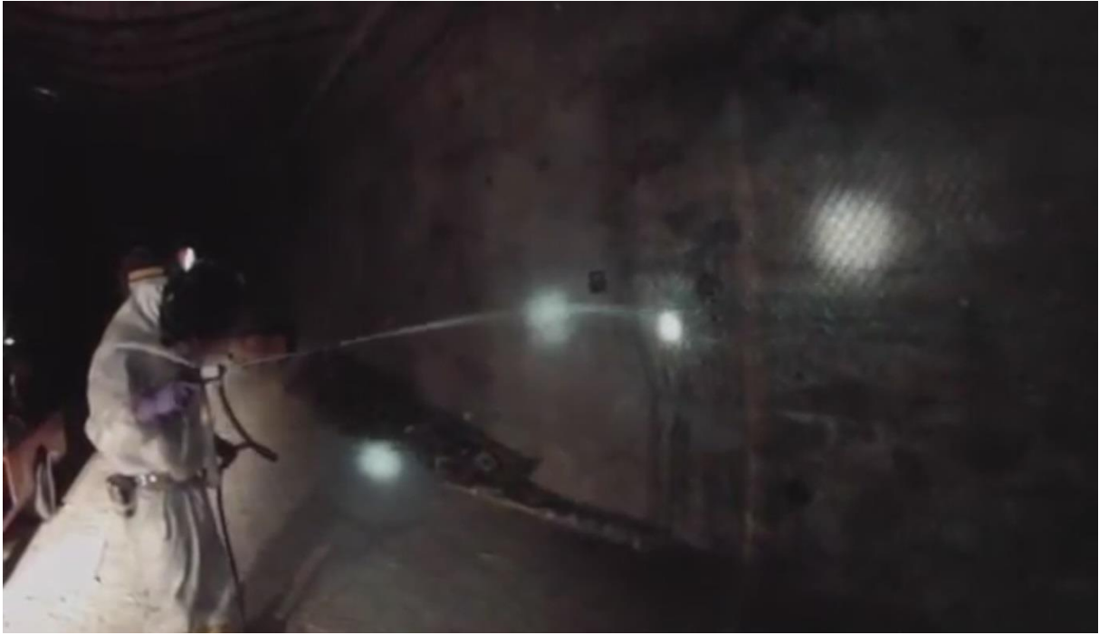
Figure 5 : projection d'eau sur les parois de l'installation souterraine, extrait vidéo [ http://www.wipp.energy.gov/Video/Mitigating_Contamination.mp4 ]
