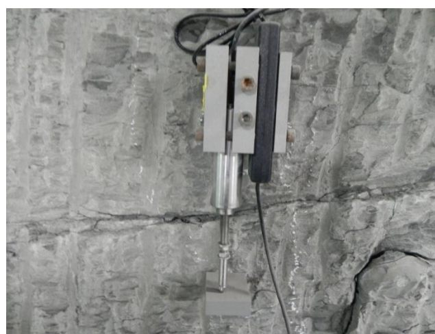
Extensomètre mesurant l'ouverture d'une fissure.
