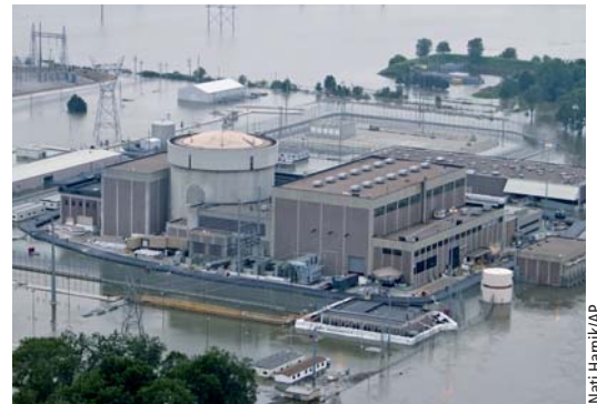
Inondation de la centrale de Fort Calhoun (États-Unis) provoquée par une crue du Missouri, en juin 2011.
