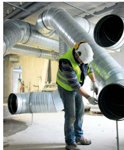
Installation de gaine de ventilation à l'EPR de Flamanville.
