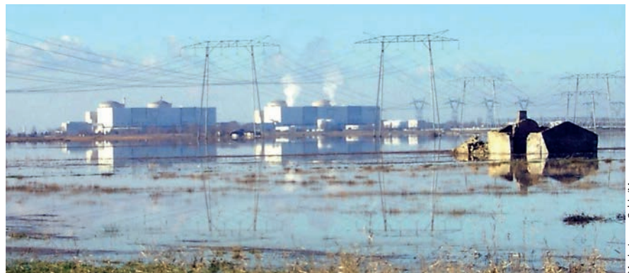
Les abords de la centrale du Blayais (Gironde), inondés en 1999.
