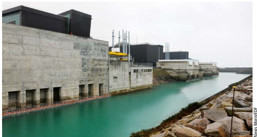
Les pertuis – ouvertures dans la façade en béton – permettent à l’eau du canal d’amenée d’entrer dans la station de pompage de l’EPR de Flamanville (Manche).
