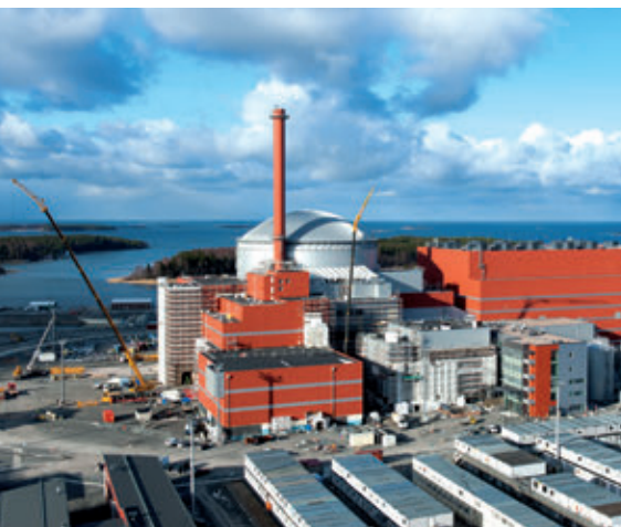
Chantier de l'EPR d'Olkiluoto (Finlande) en mars 2014.
