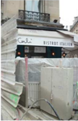
Photographie 3 - Un restaurant enmuré par le chantier
