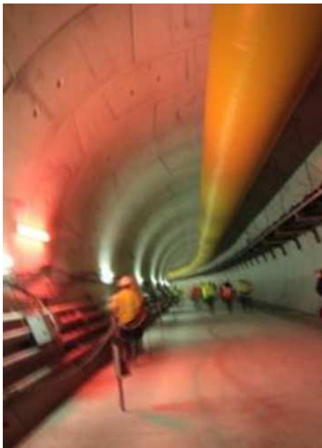
Photographie 1 - Tunnel avril 2017
