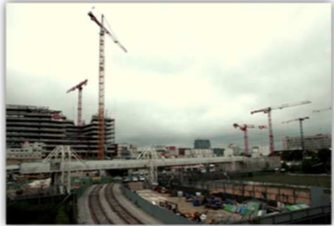
Photographie 4 - L'étendue du chantier entre la construction de la station et du tribunal de grande instance
