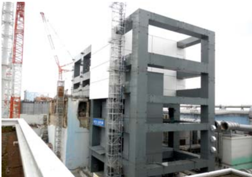
Source TEPCO - structure métallique mis en place sur le bâtiment réacteur 4
