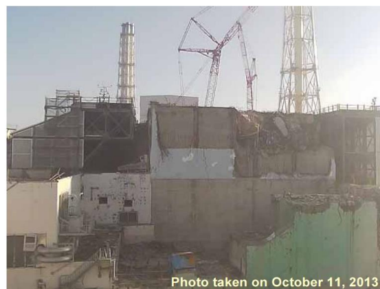
Source TEPCO - Avancement du retrait des débris du bâtiment réacteur 3 (photos prises en février 2012 et octobre 2013)
