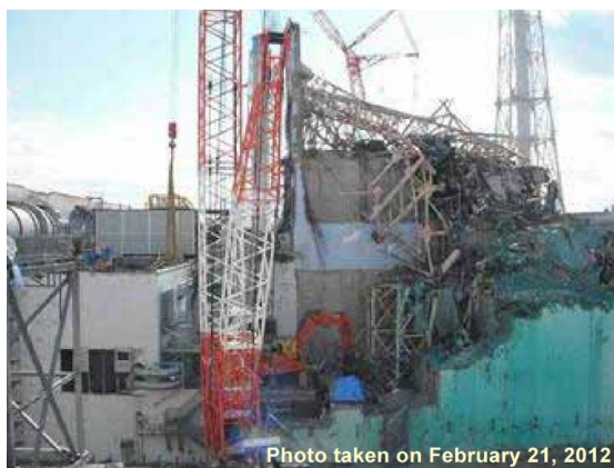
Source TEPCO - Avancement du retrait des débris du bâtiment réacteur 3 (photos prises en février 2012 et octobre 2013)
