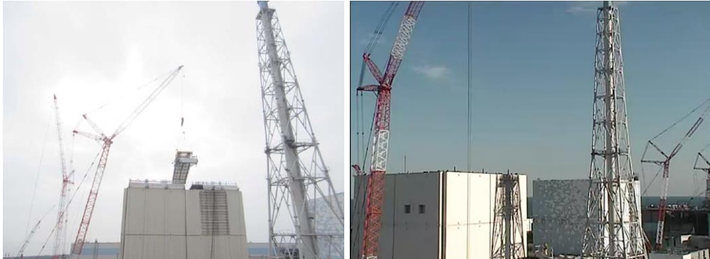
Source TEPCO - Retrait d'un panneau du bâtiment recouvrant le réacteur 1 (juillet 2015) et état actuel du bâtiment
