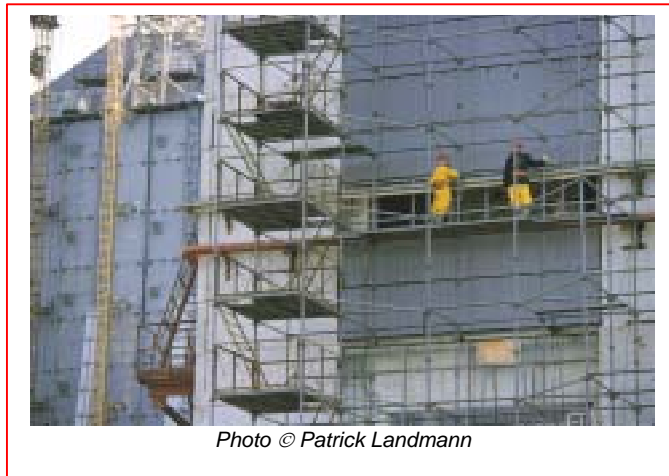
Travaux sur le sarcophage
