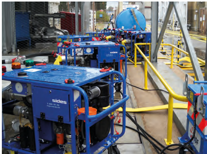
Figure C Mise en place des moyens mobiles permettant la réalimentation en eau des générateurs de vapeur
