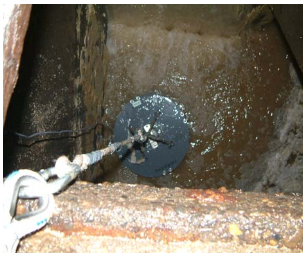
Figure 8 : Installation de la sonde dans la canalisation d'eaux usées
