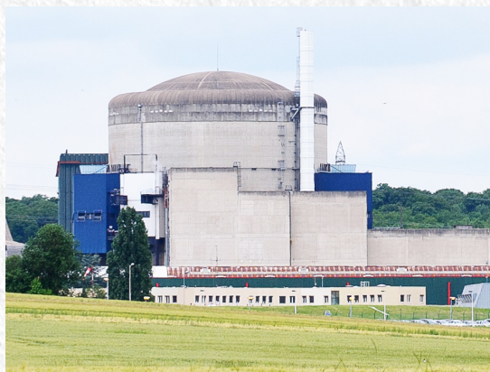
Enceinte de confinement.
