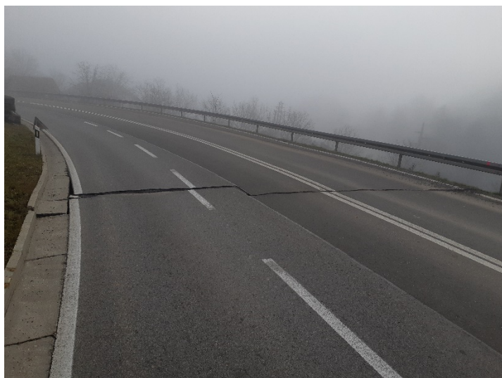
Figure 5. Deux photographies mises à disposition par le Service géologique de Slovénie, illustrant les déplacements coulissant le long de la faille de Petrinja ( https://www.facebook.com/GeoloskizavodSlovenije ), avec dans chacun des cas un déplacement relatif vers la droite des compartiments au-delà de la faille.
