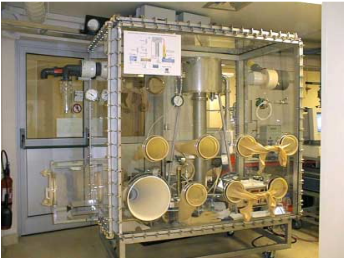
Figure 4.10 -Vue générale de l'installation en boîte à gants.
