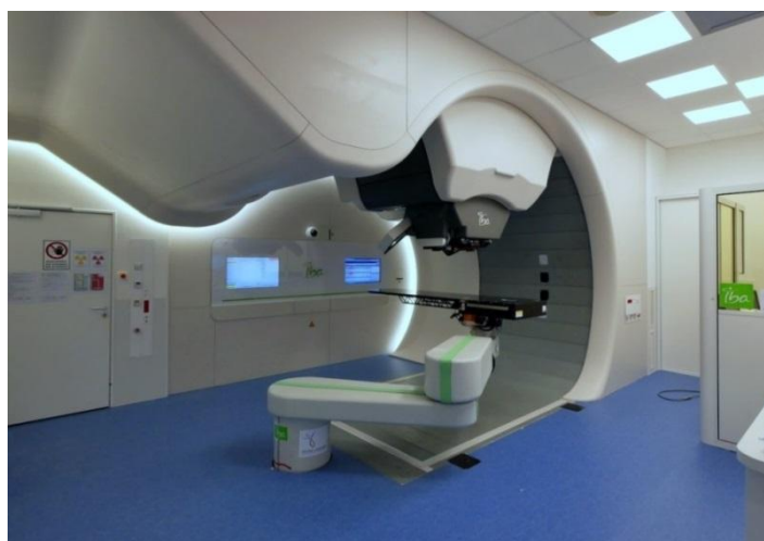
Figure I.3 Bras isocentrique compact installé au CAL.
