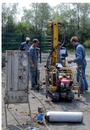
Réalisation d'un test de perméabilité sur site.
