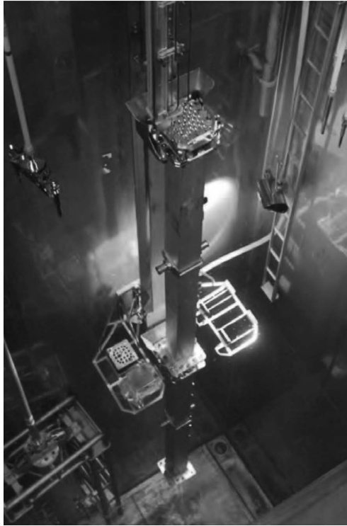
Figure 28.6. Vue du dispositif de « resqueletage » STAR dans la piscine du bâtiment du combustible. EDF.
