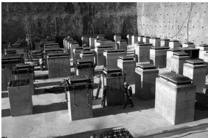
Figure 7.11. Vue, lors de la construction du réacteur Jules Horowitz (2009), des plots avec leurs patins antisismiques, d'après Le Blog des Énergies. © DR.
