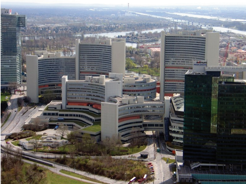
Figure 3. Vue de l’Agence internationale de l’énergie atomique (AIEA) située à Vienne, Autriche. © DR.
