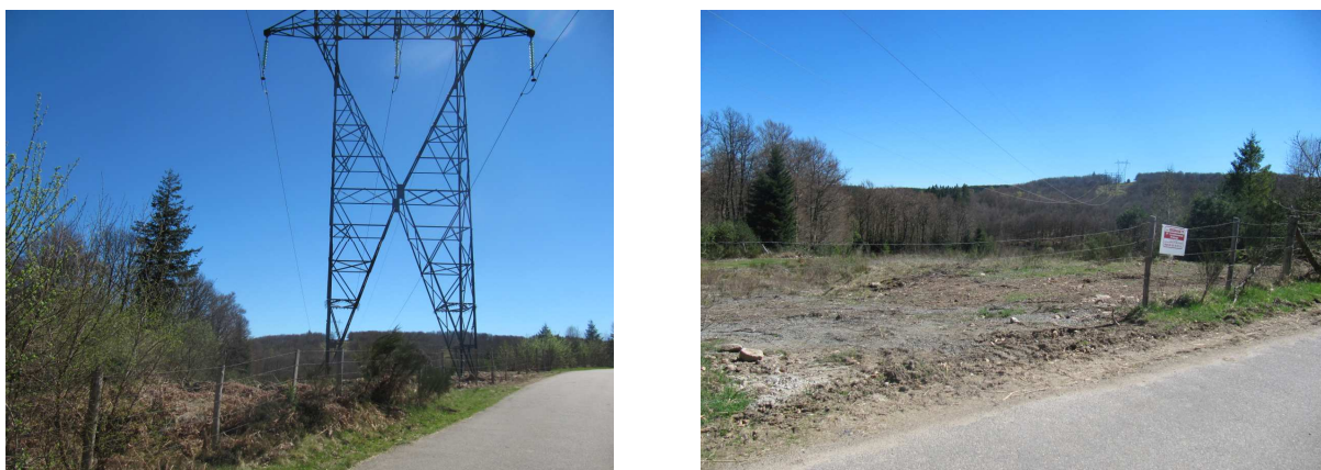
Figure 8 : Pylône électrique sur le site et terrain récemment élagué par ERDF
