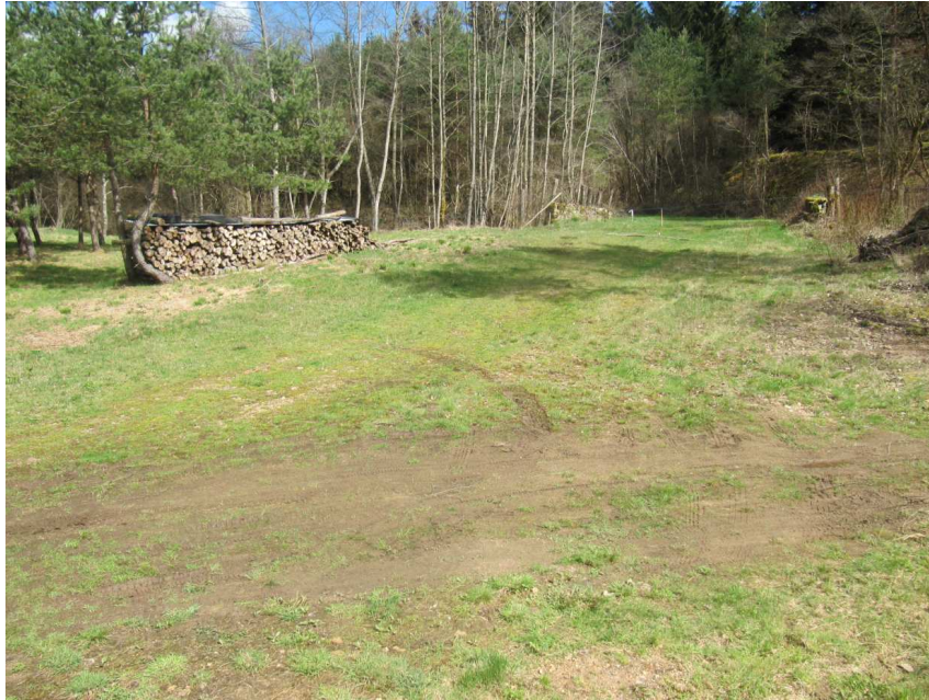
Figure 5 : Travaux de déboisement en cours en vue de la mise en place d'une clôture La verse est visible depuis le chemin d'accès et est totalement plantée de pins (Figure 6).
