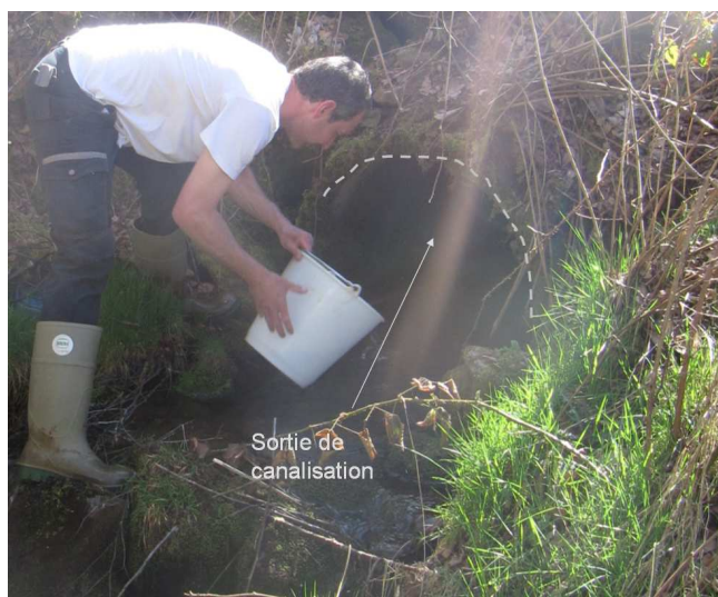
Figure 13 : Ecoulement du ruisseau La Petite Rebière via une canalisation enterrée au Sud du site Le Longy : sortie de canalisation
