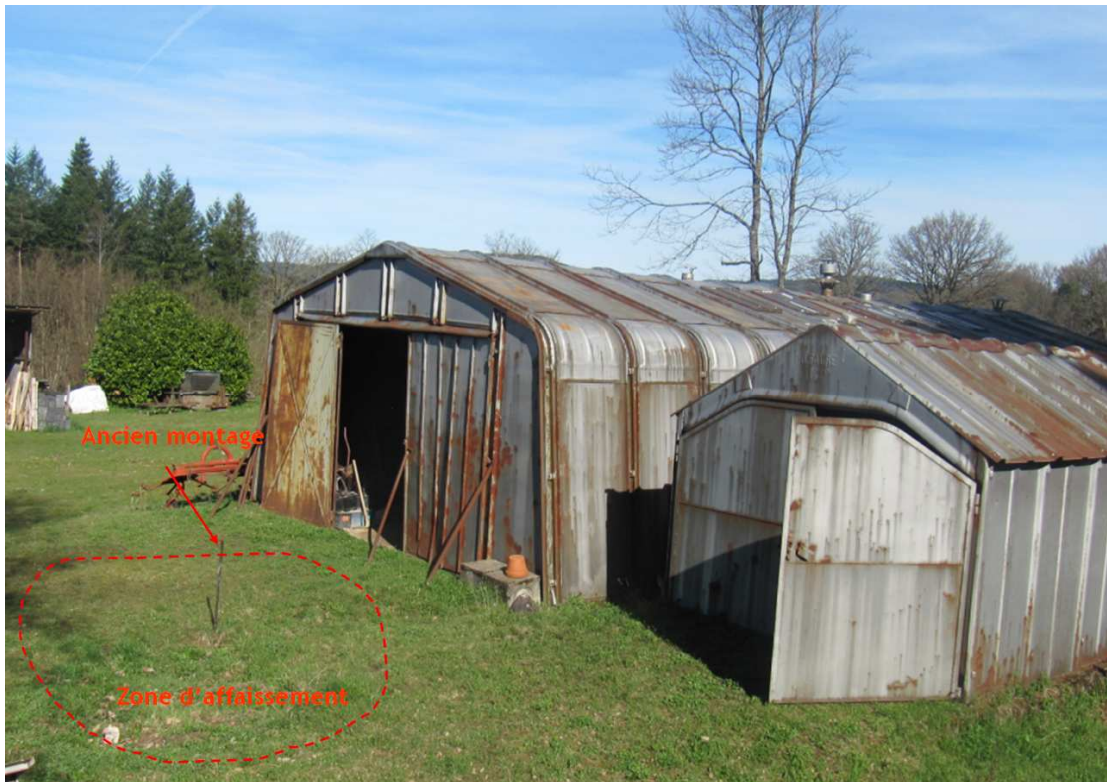
Figure 8 : Anciens baraquements en tôle à proximité de l'ancien montage
