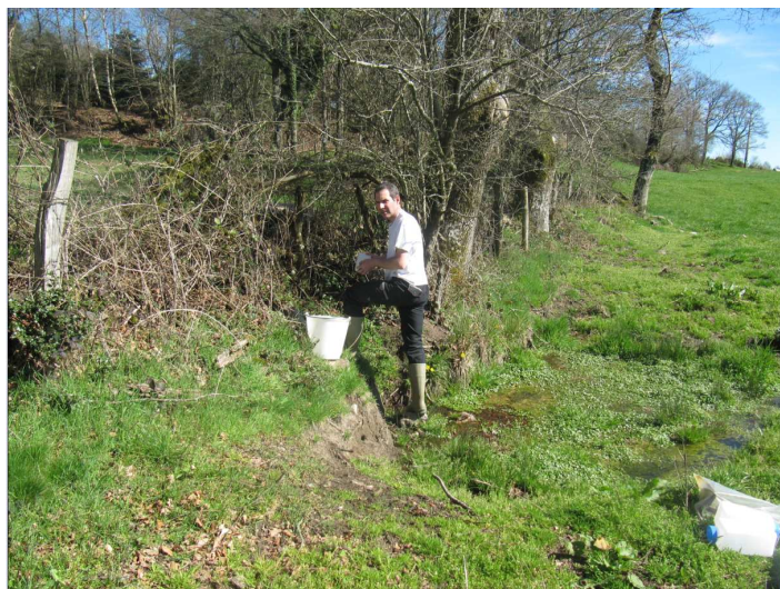
Figure 10 : Zone d'affaissement au niveau de l'ancien montage P13 supposé
