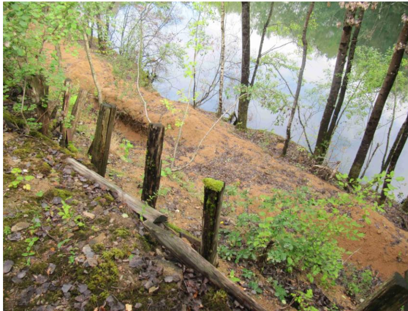
Figure 11 : Bordure Sud de la fosse en eau, en travaux : vue depuis le terrain de l'habitation.
