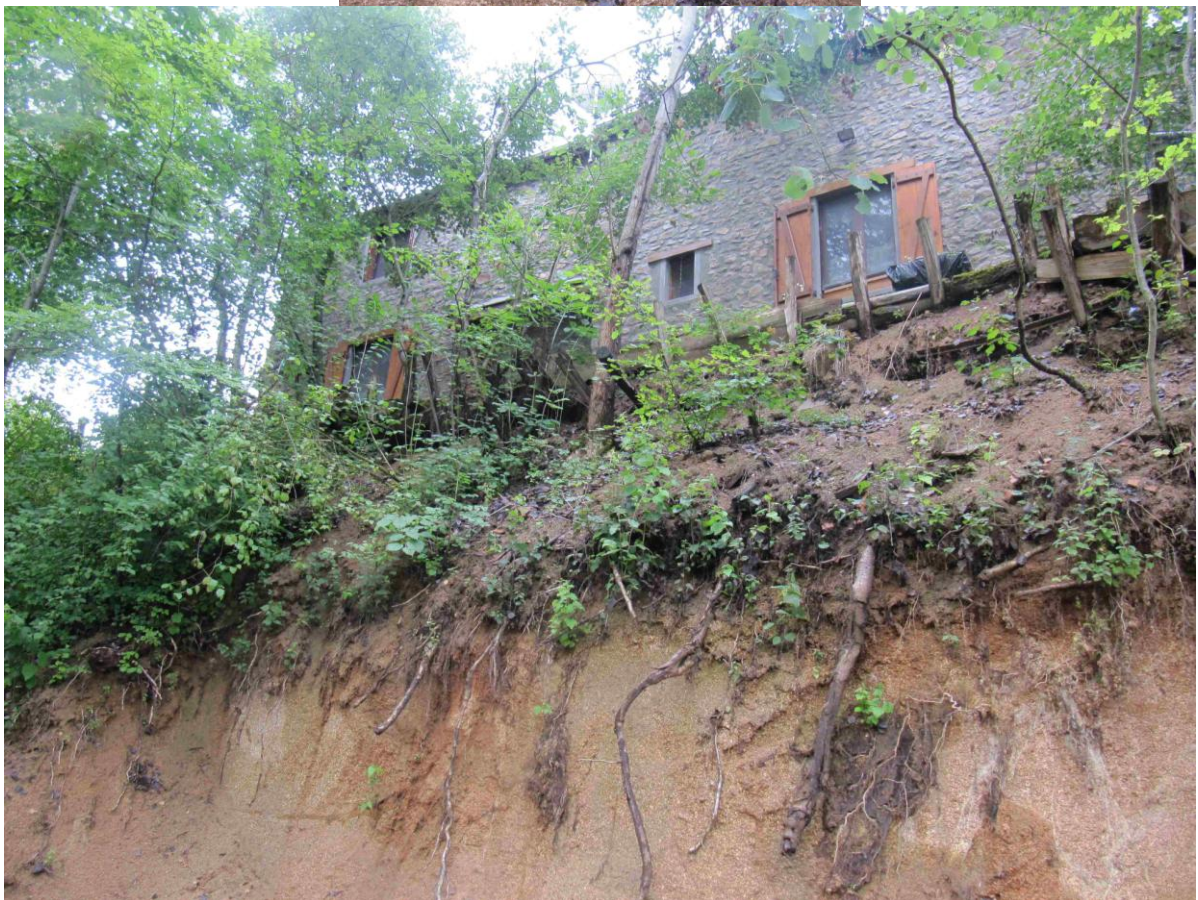
Figure 10 : Bordure Sud de la fosse en eau, en travaux, jouxtant une habitation.
