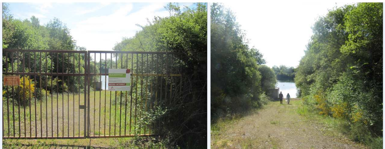
Figure 8 : Accès à la MCO en eau
