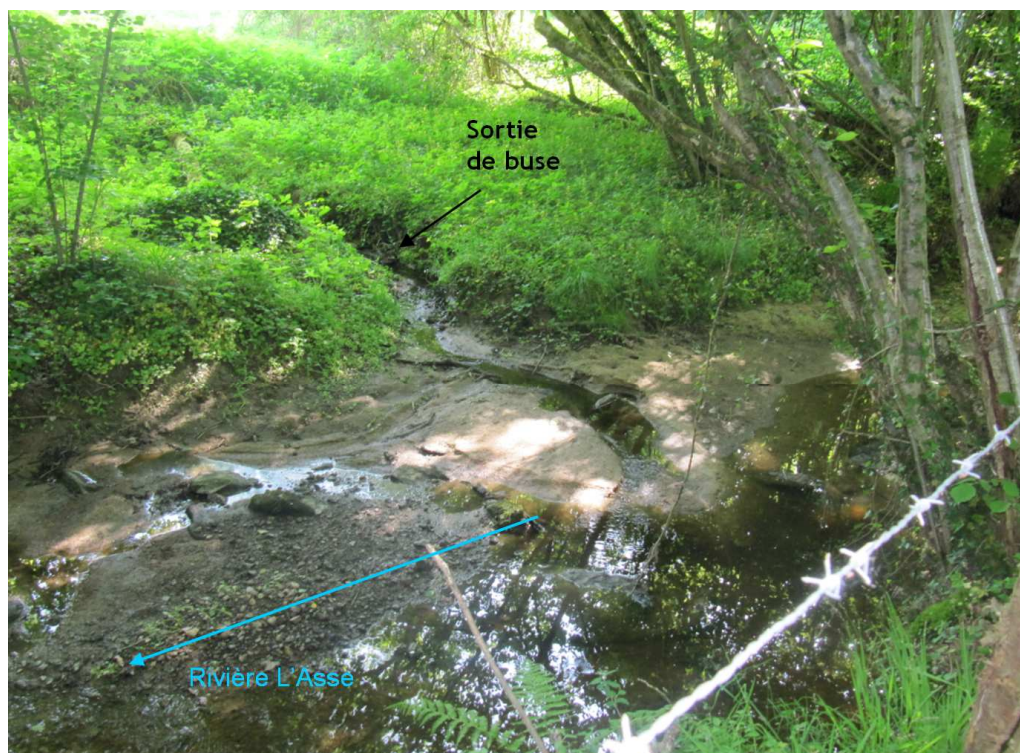
Figure 14 : Sortie de buse au niveau de la rivière l'Asse
