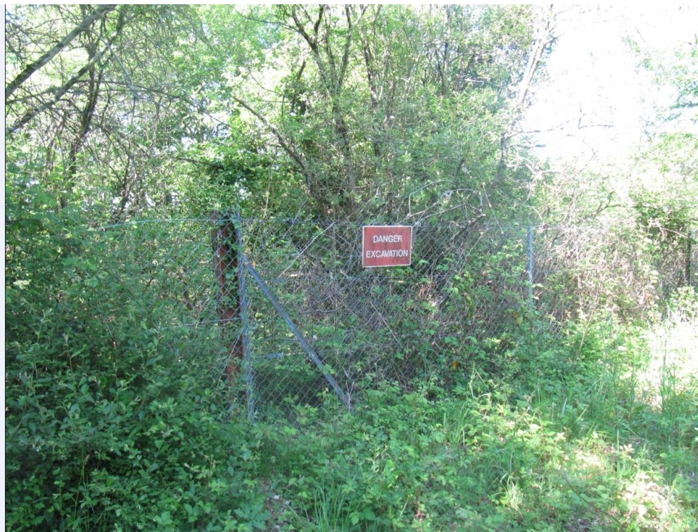
Figure 7 : Grillage autour des parements abrupts de la MCO et signalisation des dangers
