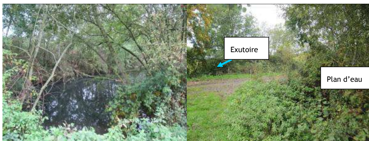
Figure 9 : Site Le Rompey. Vues du bassin et de l'exutoire du site.
