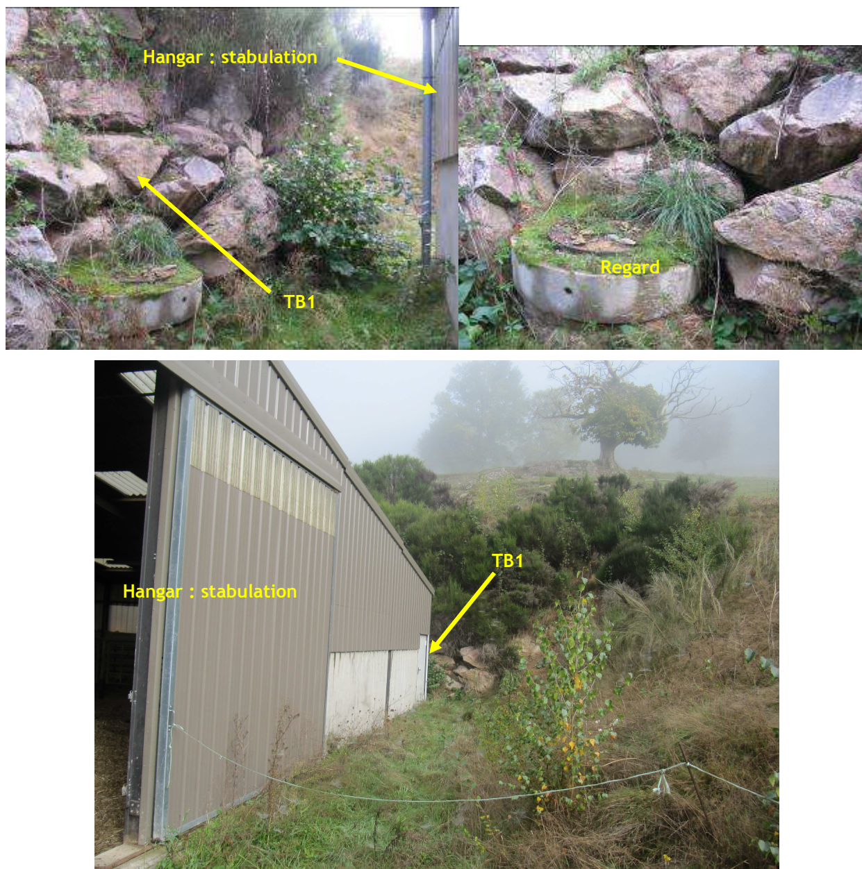
Figure 4 : Site Les Ruaux : entrée du TB1 obturée par de gros blocs de granite et regard sur les canalisations des eaux provenant des TMS (prélèvement IRSN M_RUA_TB1).
