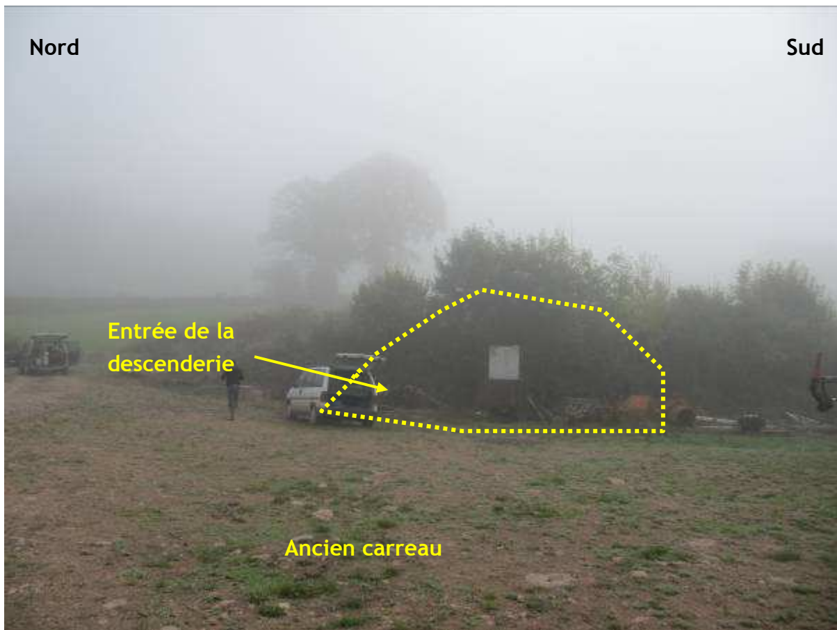
Figure 6 : Site Les Ruaux : vue sur l'ancien carreau et l'emplacement de l'entrée de l'ancienne descenderie.
