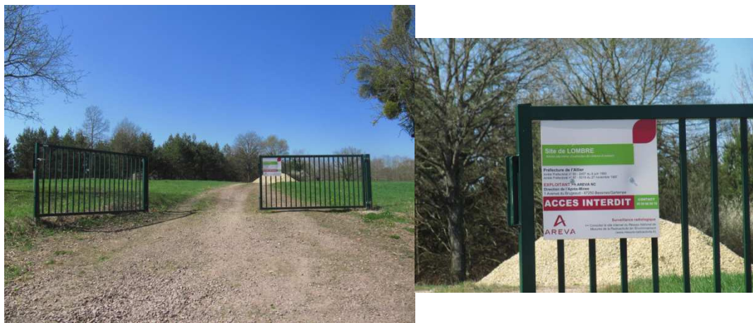
Figure 9 : Entrée du site depuis la route communale : portail et affichage
