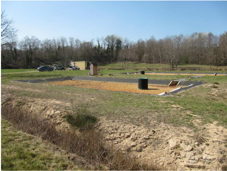
Figure 6 : Vue générale de la station de traitement des eaux du site Lombre
