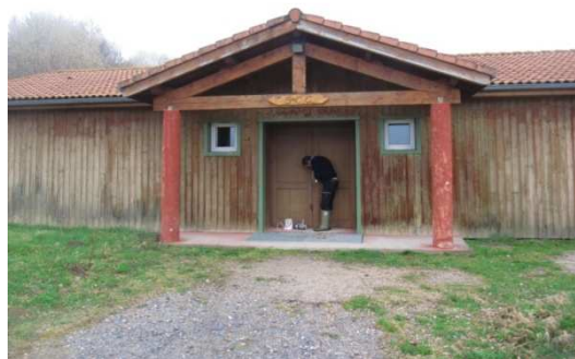
Figure 7 : Local vestiaire entre les deux terrains de football
