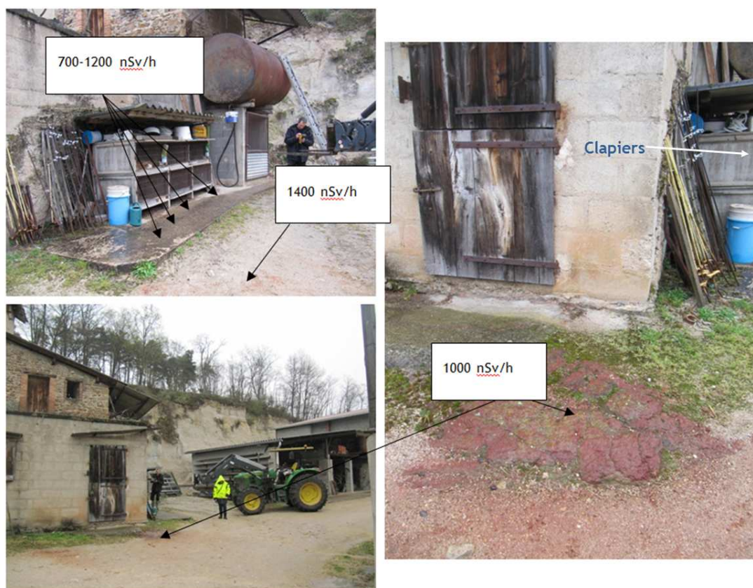
Figure 9 : Zone d'affleurement au lieu-dit Chez Dragon
