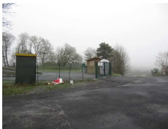
Figure 8 : Déchetterie sur l'ancienne aire de stockage du minerai
