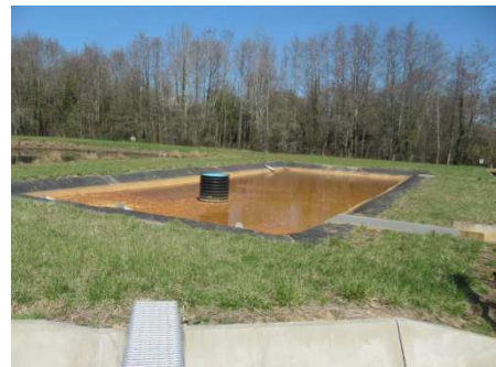
drains sur paille d'orge (gauche); premier bassin de décantation (centre); drains calcaires (droite)
