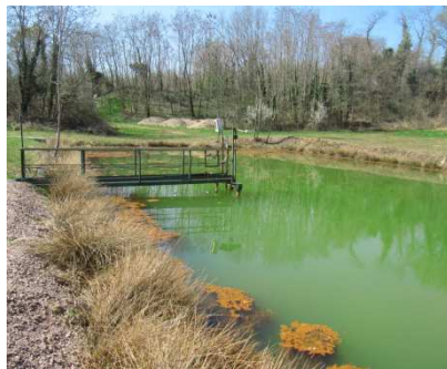
drains sur paille d'orge (gauche); premier bassin de décantation (centre); drains calcaires (droite)
