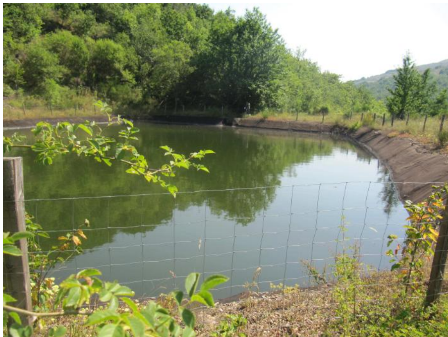
Figure 7 : Ancien bassin de décantation avant le rejet
