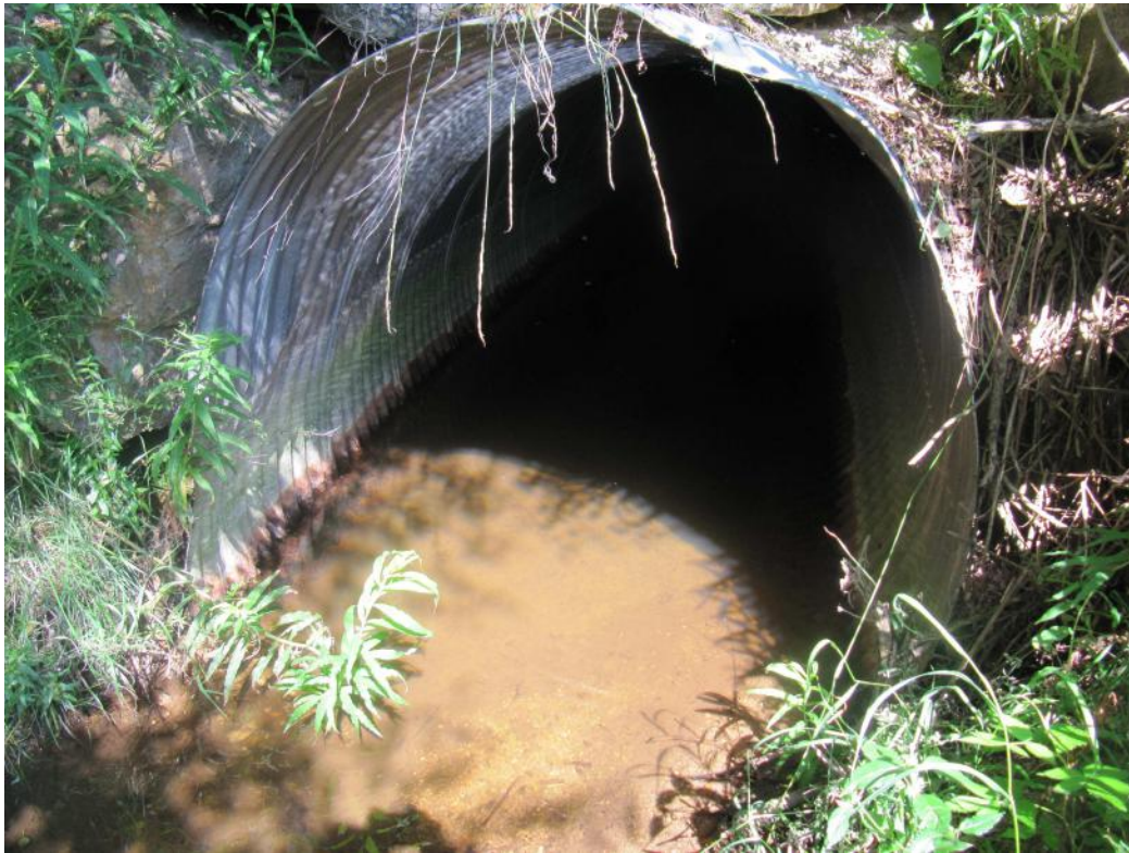
Figure 6 : Exutoire du site Le Villeret
