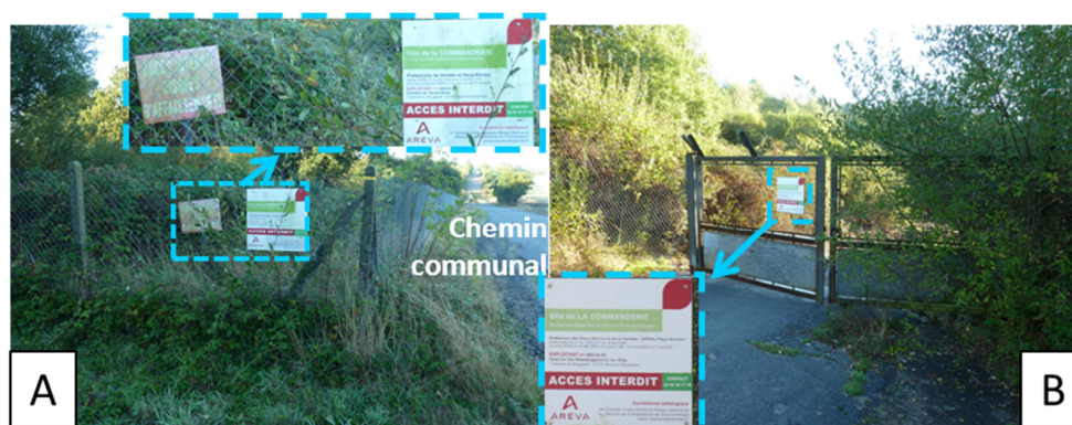
Figure 45 : A- Grillage autour de la zone Nord du site et panneaux d'interdiction et d'avertissement ; B-Portail d'accès à la MCO
