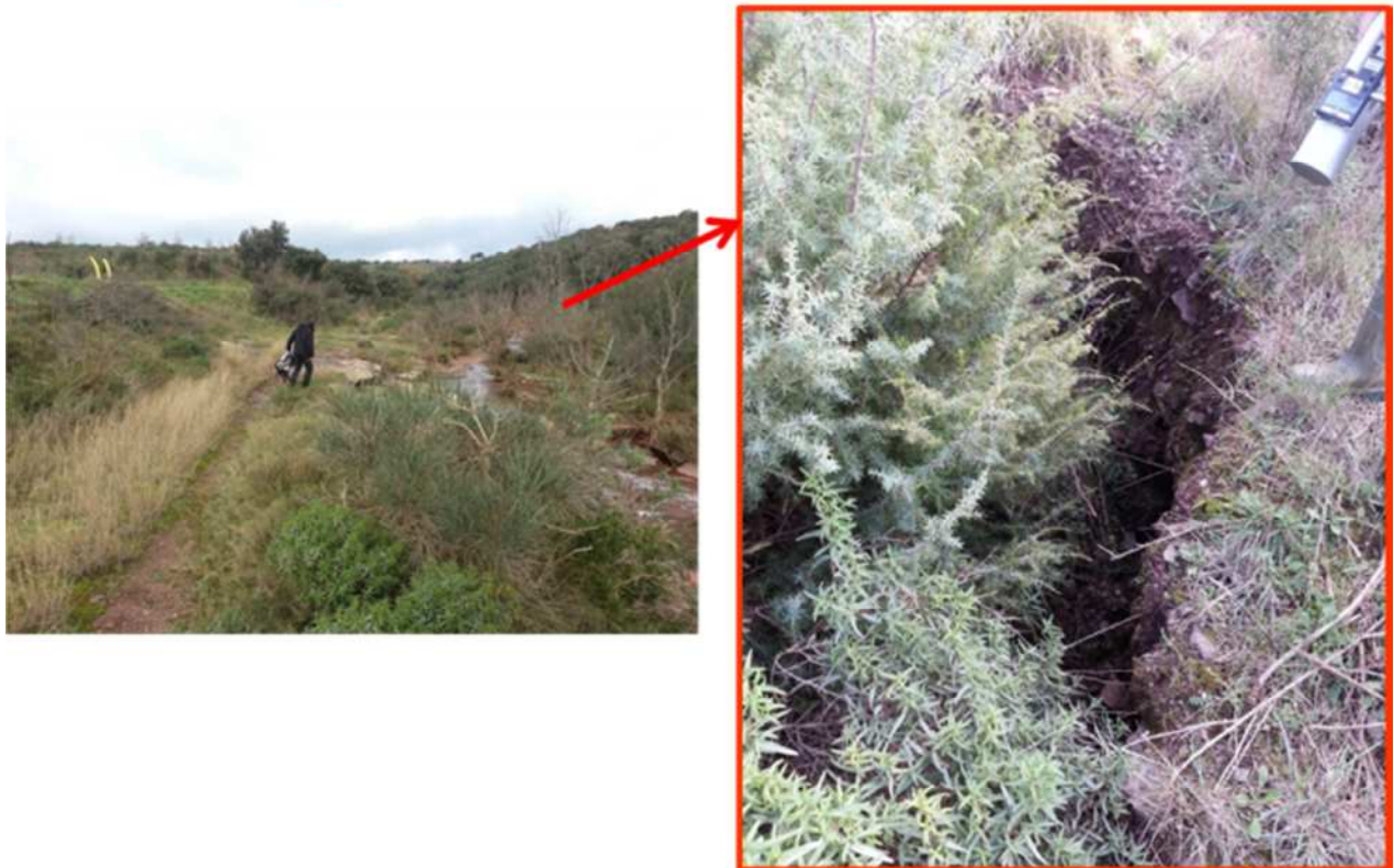
Figure 20 : Localisation de l'ancien puits sur le site de Rabejac (sur fonds de carte extrait du BE d'Areva Mines [2]) et vue de l'ancien puits effondré sur la verse à stériles du chantier de Rabejac Est avant sa mise en sécurité par Areva Mines suite aux contrôles de second niveau de l'IRSN de décembre 2014 (© IRSN)
