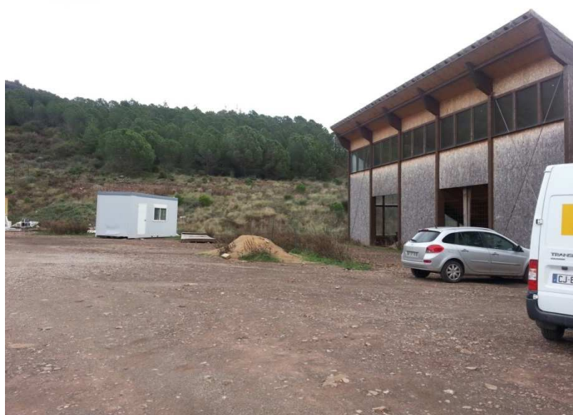
Figure 23 : Plateforme aménagée sur l'ancien carreau minier, occupée par un gestionnaire de panneaux solaires (IRSN©)
