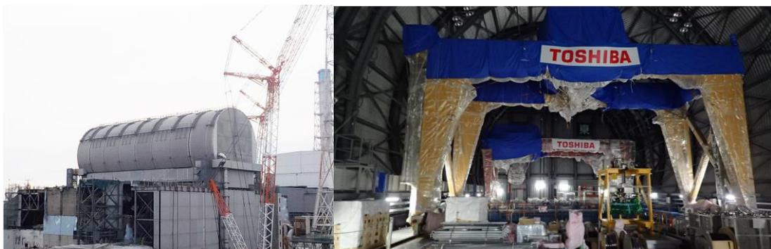
*Source TEPCO - Vue de la structure recouvrant le bâtiment du réacteur 3 (état en février 2018) et des moyens de manutention du combustible qui y sont implantés - Source TEPCO*
