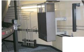
Mise en place de recombineurs d'hydrogène (2007 sur tous les réacteurs)
