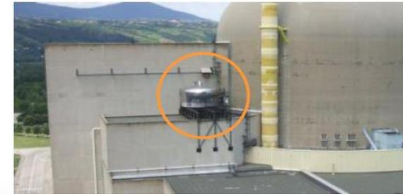
Mise en place d'un dispositif d'événage-filtration des enceintes pour contrôler la pression (années 90)
