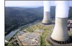
1 - Chooz Ardennes, à 60 km de Charleville-Mézières Réacteur à eau pressurisée Mise en service : 1967 Date d'arrêt : 1991
