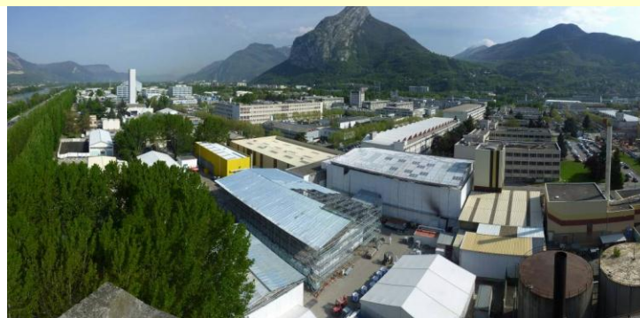
Traitement Déchets & Effluents (1964-2003)
