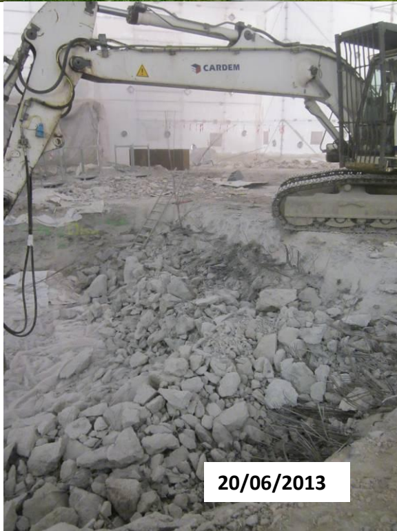
Démolition du radier
