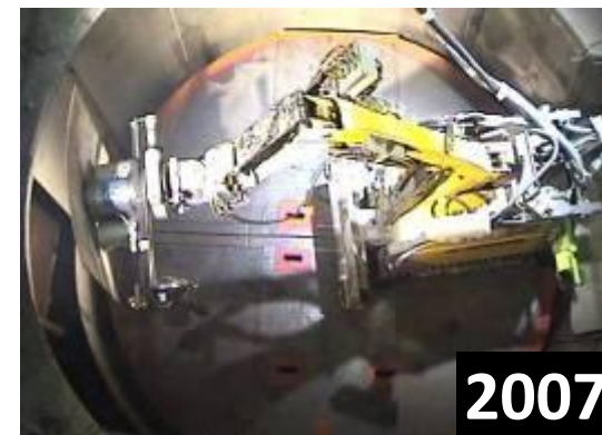
Décuvelage piscine en télé opéré
