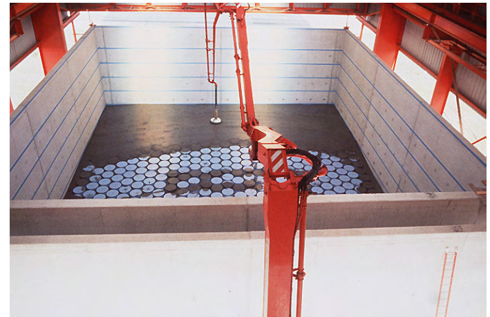
Enrobage au mortier
