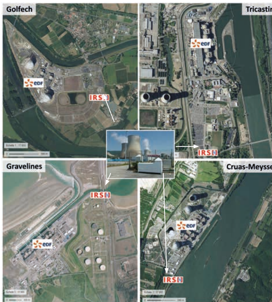
FIGURE A / IMPLANTATION DES STATIONS DE COLLECTE D'AÉROSOLS DE L'IRSN À PROXIMITÉ DES 4 CNPE D'EDF (source : vues aériennes géoportail)
