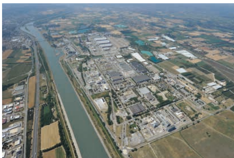
Vue aérienne du site du Tricastin
