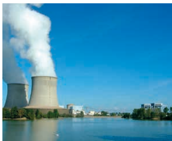
CNPE de Saint-Laurent-des-Eaux
