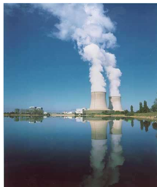
Figure 8 : CNPE de Saint-Laurent-des-Eaux (© EDF)
