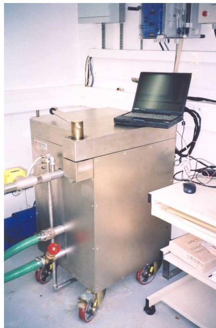
Figure 43 : Cuve blindée d'une station Hydrotéléray
