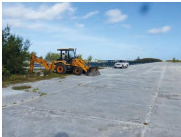
Figure 16. Excavation pour un échantillonnage de sol à 3 mètres des dalles en direction du lagon.
