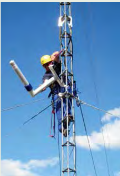
Figure I.11 - Installation d'une balise Téléray de nouvelle génération sur le mât de transmission d'une gendarmerie.
