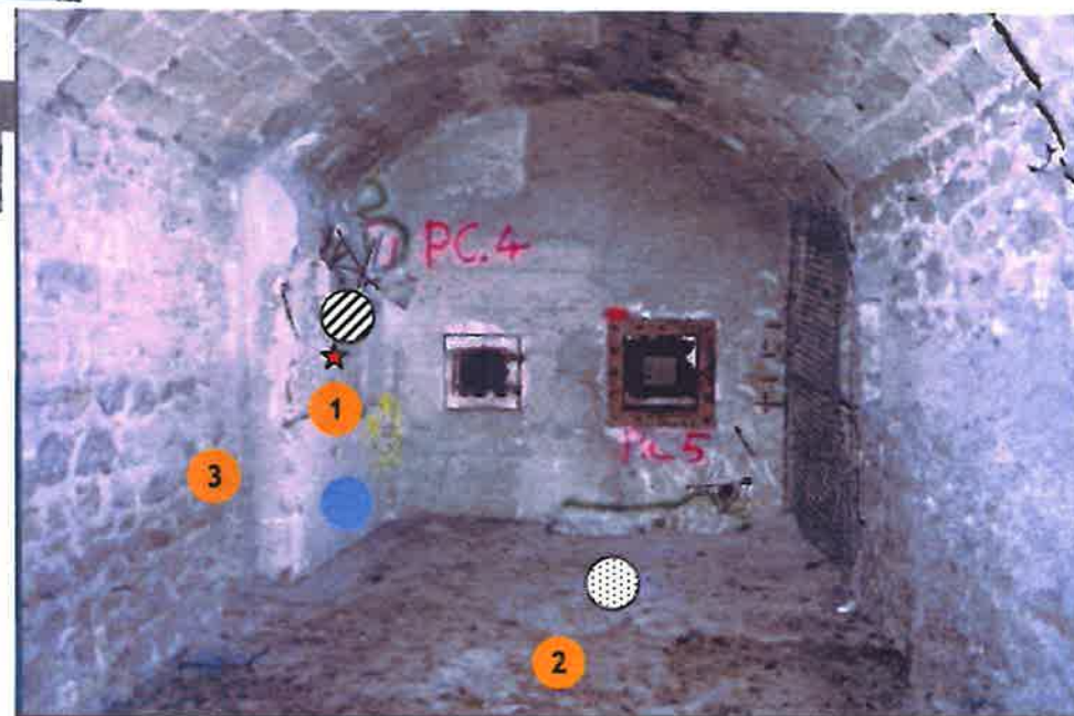
Vue du couloir d'accès depuis l'entrée
