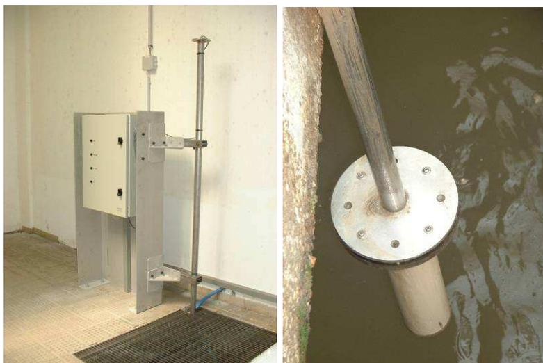
Figure 66 : Photos d'une station Télhydro (vue générale et détaillée de la sonde)
