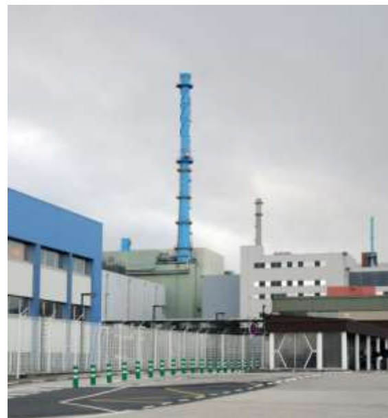
Figure 2.25 - Cheminée de ventilation de l'usine UP3-A AREVA NC La Hague
