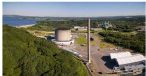
Figure 3.7 - Vue de l'installation EL4-D sur le site des Monts d'Arrée
