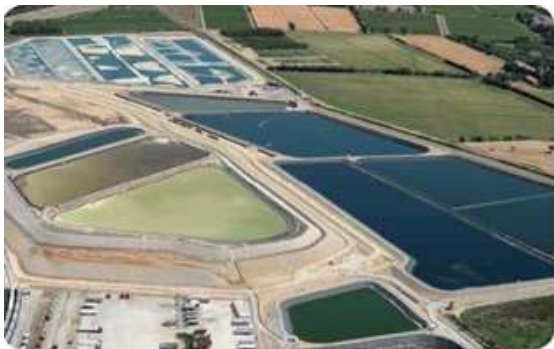
Figure 1.5 - Les bassins de décantation et d'évaporation du site de Malvési
