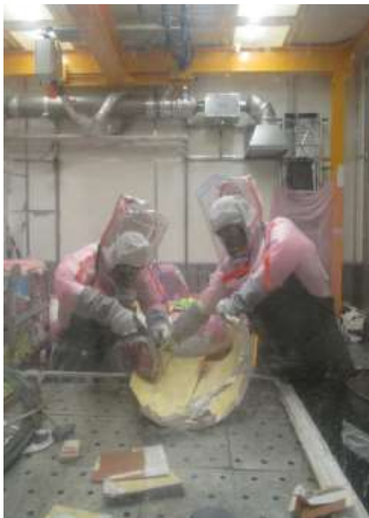
Figure 3.4 - « Plongeurs » en intervention sur un chantier de démantèlement
