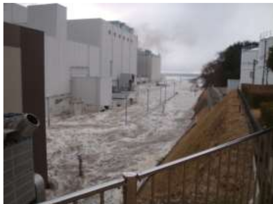
Figure 4.1 - Inondation sur le site de la centrale de Fukushima Daiichi provoquée par le tsunami du 11 mars 2011
