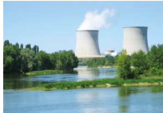
Figure 1.1 - Vue des aéroréfrigérants de la centrale nucléaire de Saint-Laurent-des-Eaux B
