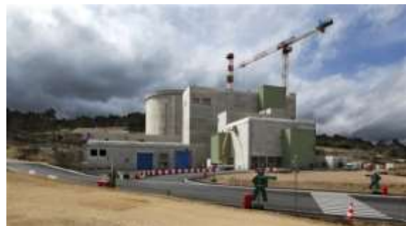
Vue générale du Réacteur Jules Horowitz (RJH) en construction
