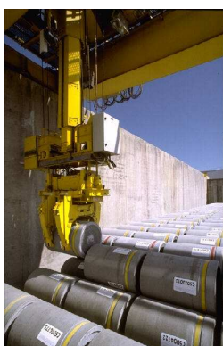
Aire ADT - entreposage de colis de déchets bétonnés (AREVA La Hague)
