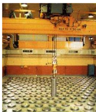
Atelier CASCAD - entreposage de combustibles usés dans des conteneurs (CEA Cadarache)
