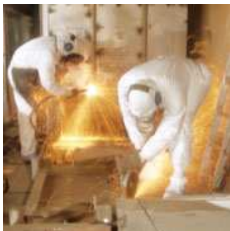
Travaux de découpe avec une disqueuse
