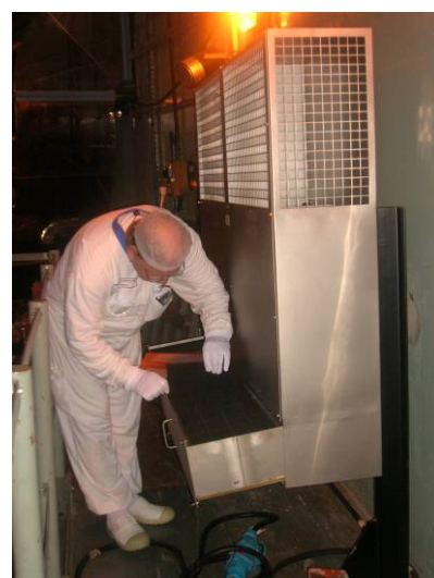
Recombineur de type AREVA-NP, équipant les réacteurs de 900 MWe
