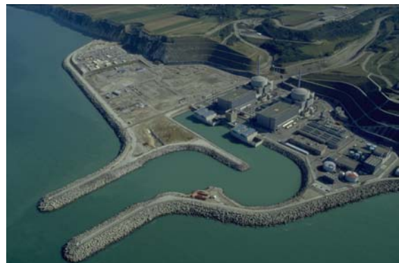
Canal d'amenée à la centrale de Penly
