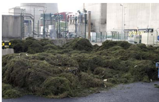
Masse de plantes à l'origine du colmatage
