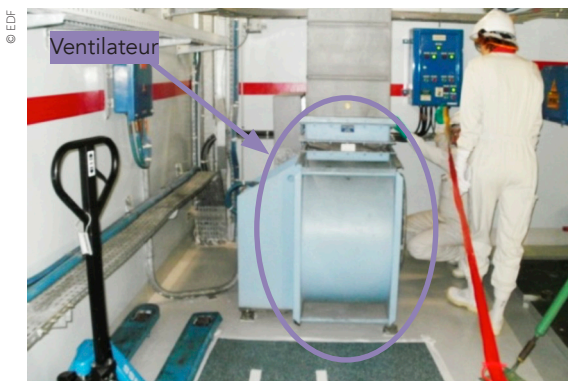
Fig. 3.4 / Ancrage de ventilateur.
