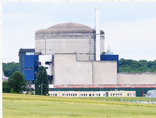
Enceinte de confinement.
