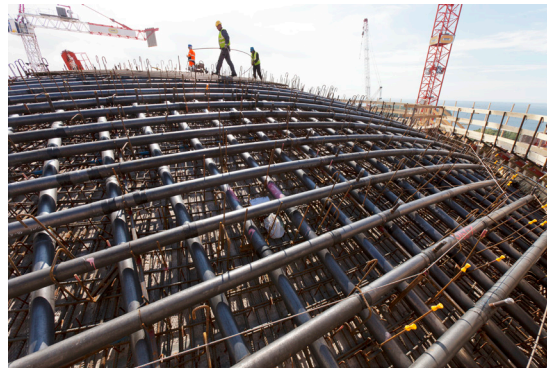
Pose de câbles de précontrainte.
