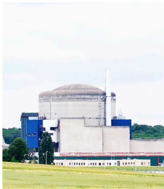
Fig. 4.2 / Une enceinte de confinement vue de l'extérieur.
