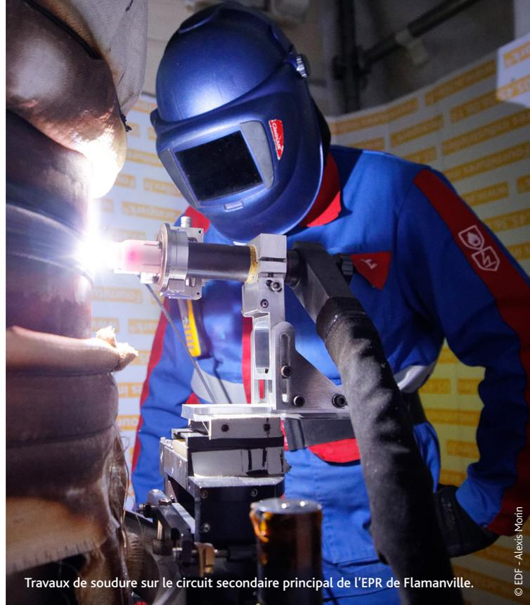
Travaux de soudure sur le circuit secondaire principal de l'EPR de Flamanville.
